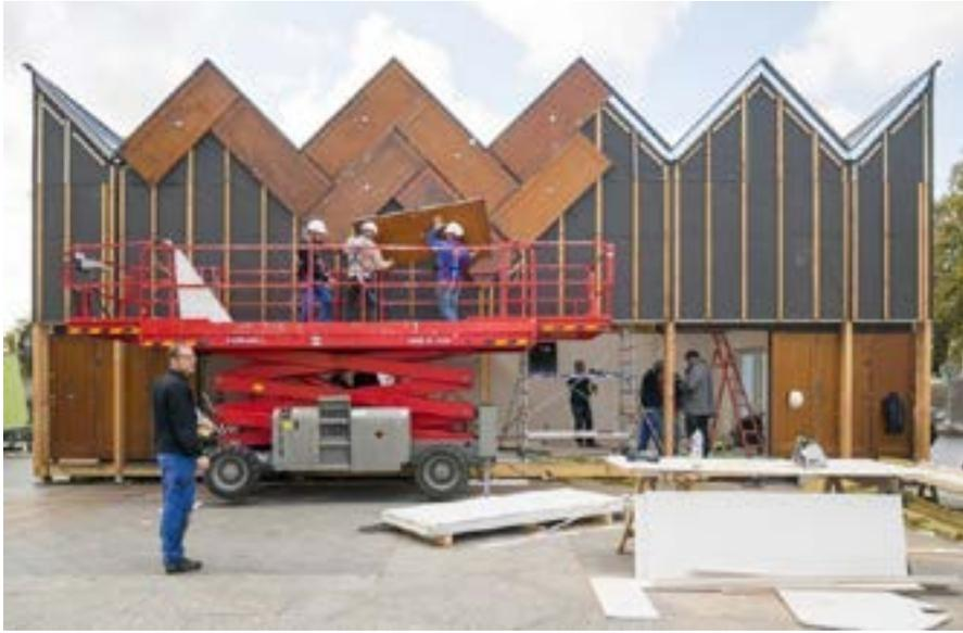
*Fig. 16 - Pavillon circulaire, la pose des anciennes portes en guise de bardage (photo, Encore Heureux)*
