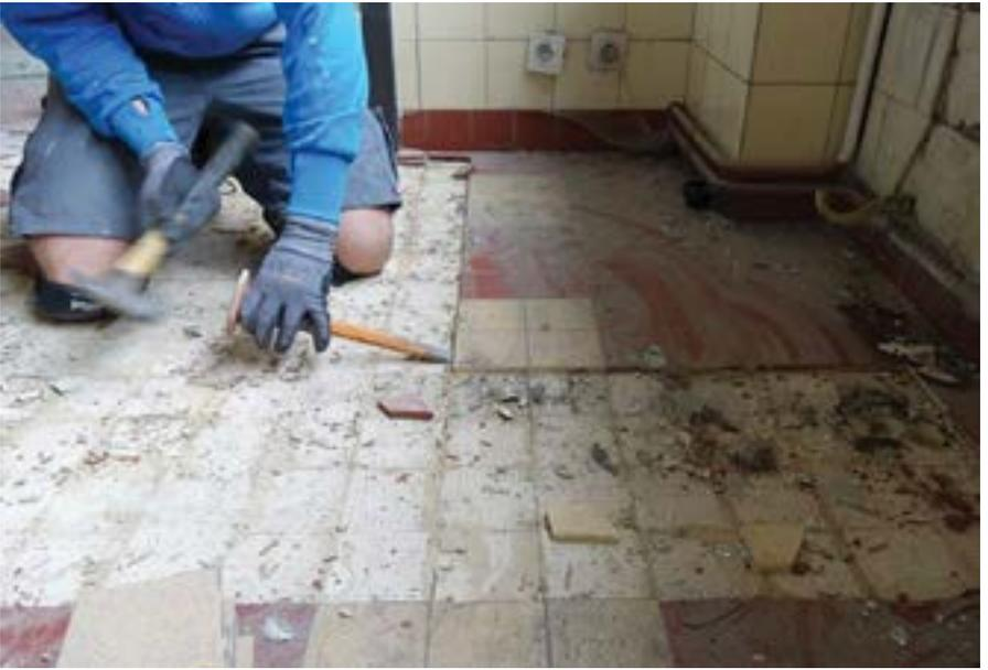
*Fig. 11 - Rotor déconstruction, opération de dépose des carreaux de ciment (photo, Rotor)*
