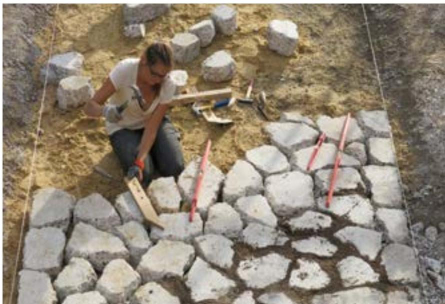
*Fig. 14 - Expérimentation d'un dallage en Opus Incertum réalisés avec les matériaux in-situ, à l'Actlab
